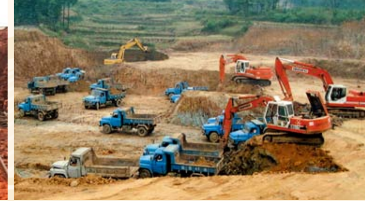
土方开挖 Earth excavation
