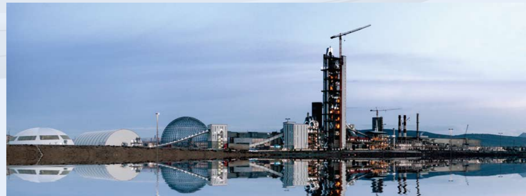
阿塞拜疆总承包项目 ( 4000 t/d ) EPC Project in Azerbaijan (4000 t/d)
