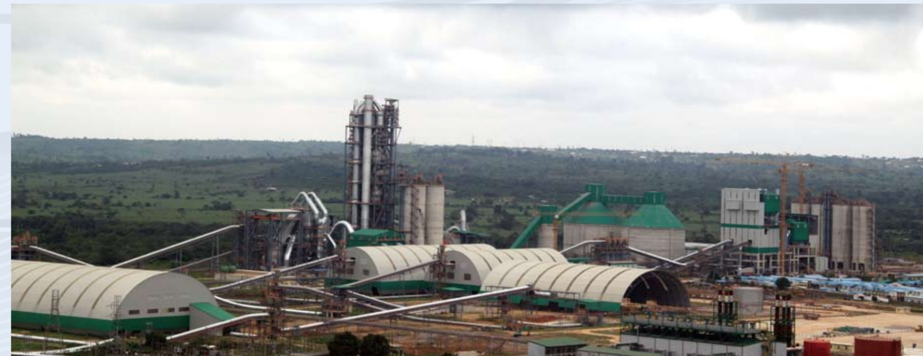
尼日利亚EWEKORO总承包项目 ( 5000 t/d ) EWEKORO EPC Project in Nigeria (5000 t/d)
